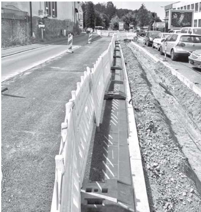
Abb.: fertiggestellte Asphalttrag- u. Binderschicht; Rinnen und Bordsteine
