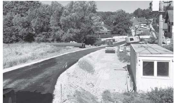
Abb.: fertiggestellte Behelfsumfahrt
