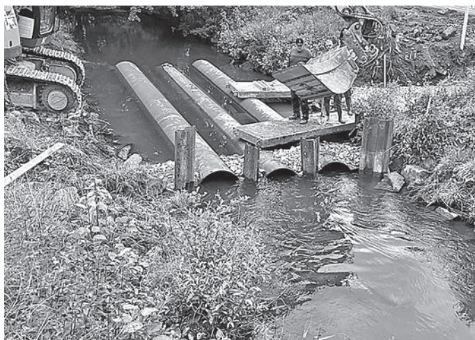
Abb.: Herstellung der Behelfsbrücke
