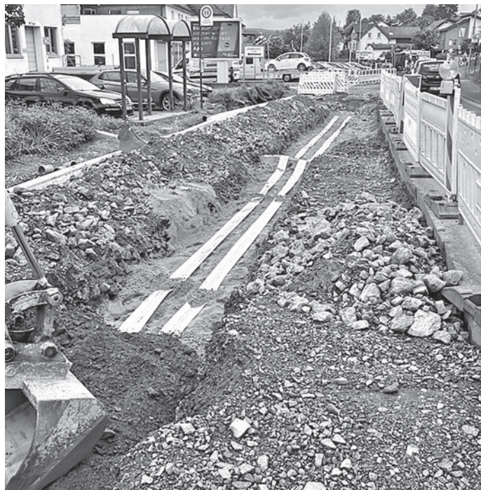
Abb.: Verlegung 20kV Stromleitung
